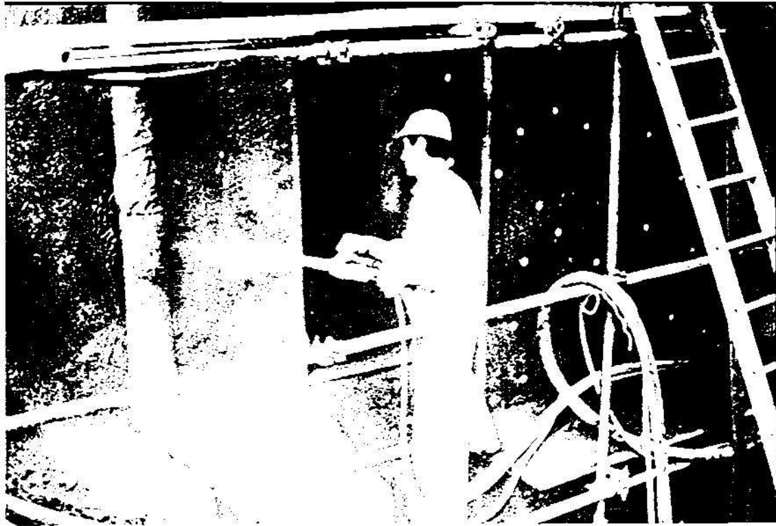
Fig. 17 - Spruzzatura finale sulla parete verticale
