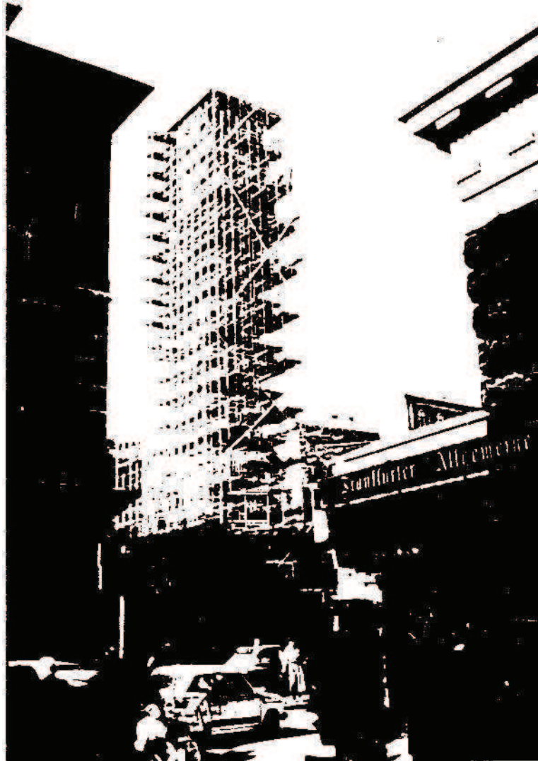
Fig. 3 - Struttura provvisoria in acciaio per sostenere i mensoloni durante le fasi di rimozione del massetto di riempimento dello scavo di alleggerimento superiore, di smontaggio delle grappe e di bonifica delle sponde frammentate.
